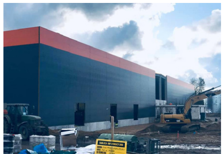
Bau des Betriebs „Zbyszko Company“ in Piła
