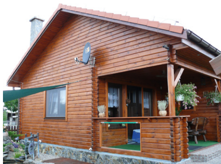
ZODAN – Betrieb für Holzverarbeitung (Beispiel eines einstöckigen Hauses mit überdachter Terrasse)
