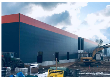
Budowa zakładu „Zbyszko Company” w Pile
